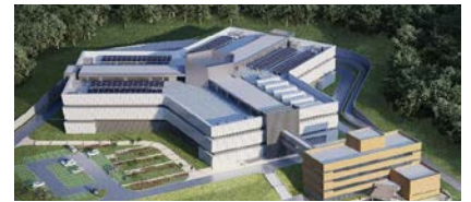
(춘천DC) 태양광 발전시설
