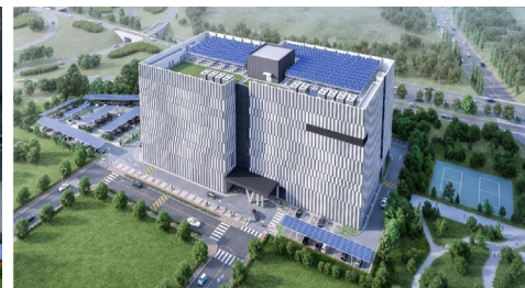
동탄 데이터센터 태양광 발전 설비
