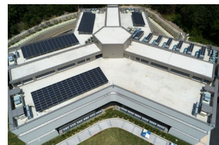
춘천 데이터센터 태양광 발전시설
