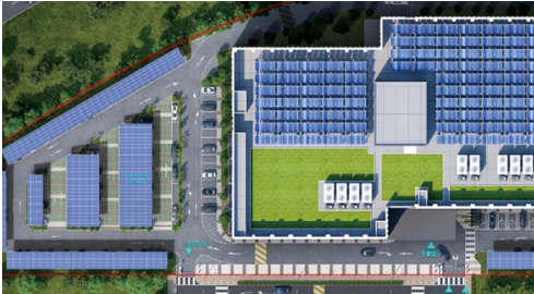
동탄 데이터센터 태양광 발전 설비
