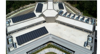
춘천 데이터센터 태양광 발전시설
