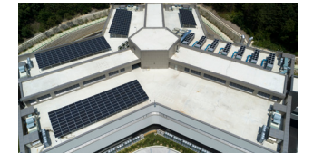
춘천 데이터센터 태양광 발전시설
