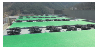
춘천DC 차양막 설치
