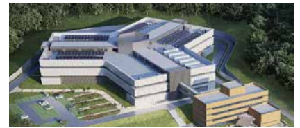
(춘천DC) 태양광 발전시설
